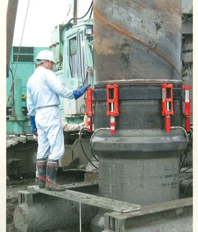
●内リングと外リングの嵌合（杭径1100mm）
