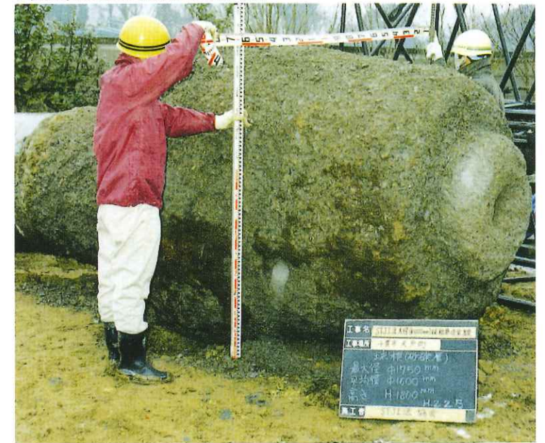
▼杭径1,000mmの球根築造掘出し状況
