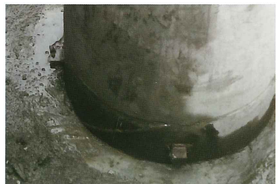
施工後の杭頭部掘削状況
