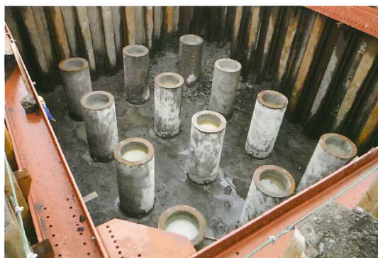
施工後の杭頭部掘削状況
