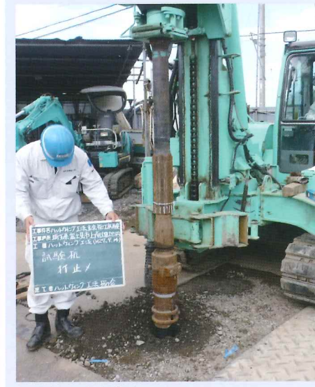
打設完了 (打ち止め)
