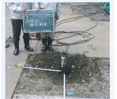
打設完了 (偏芯確認)
