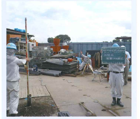
打設完了 (レベル確認)
