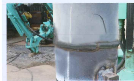
継手溶接完了
