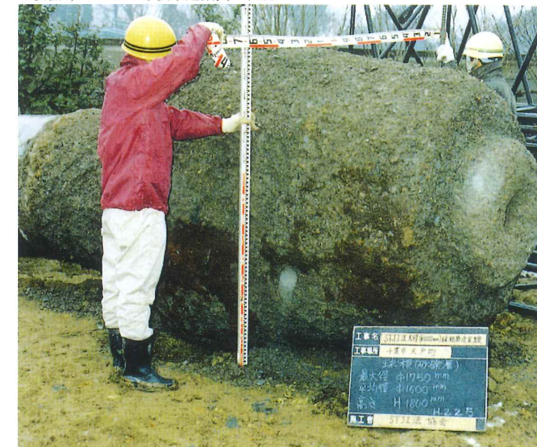
▼杭径1,000mmの球根築造掘出し状況
