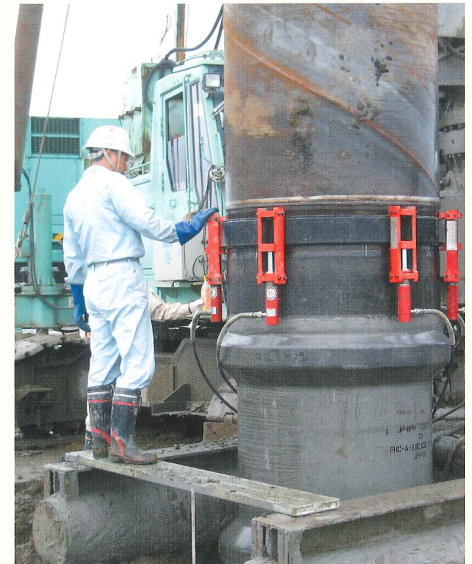
● 内リングと外リングの嵌合 (杭径1100mm)
